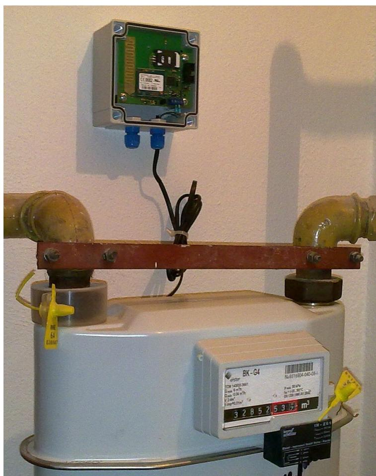
Obr. 8: Příklad montáže modulu WG-SI2 k plynometru
